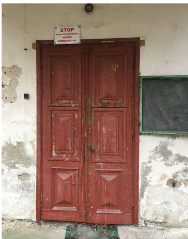
Fot. Dworek Ryxów, stolarka drzwiowa drzwi wejściowych w konstrukcji ramowo płycinowej, elewacja frontowa.
