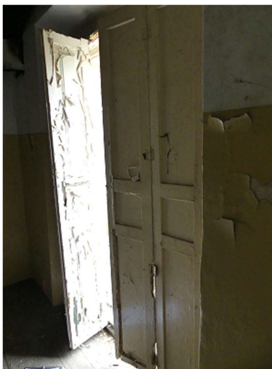
Fot. Dworek Ryxów w Prażmowie, elewacja frontowa, istniejąca stolarka okienna i drzwi balkonowych wraz z okiennicami wewnętrznymi.
