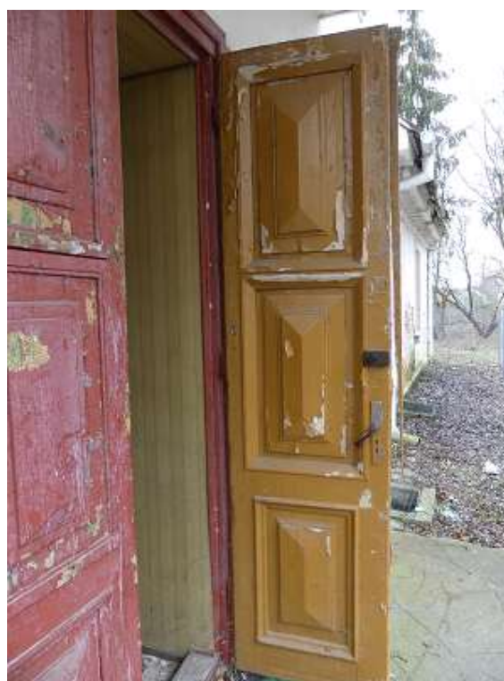
Fot. Dworek Ryxów, stolarka drzwiowa drzwi wejściowych w konstrukcji ramowo płycinowej, elewacja frontowa.
